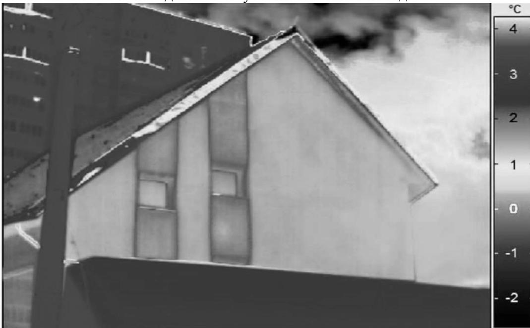
Рис. 2. Фото обыкновенного здания (рис.4), на котором видны мостики тепла в швах между кладкой блоков, в углах, под окнами, в самих окнах и т.д.
