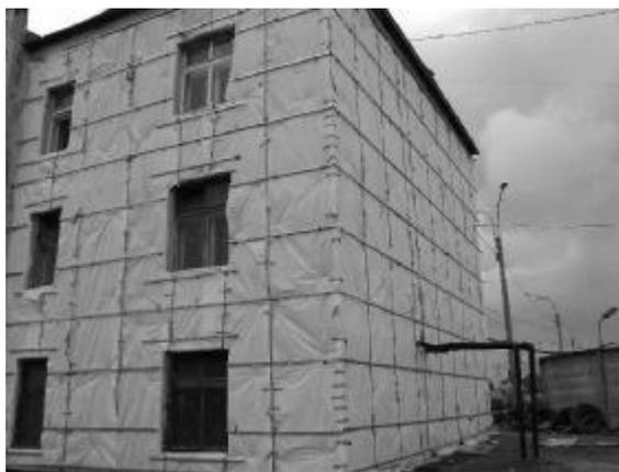
**Рис. 2. Утепление фасада здания плитами минеральной ваты «Rockwool»**
