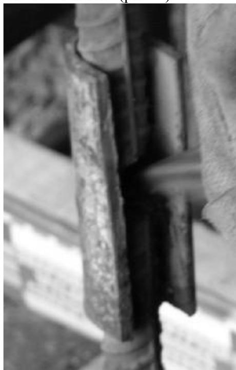
Рис. 4. Очистление шва от шлака
