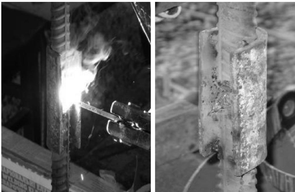
Рис.2. Выполнение корневого шва и проварка фланговых швов
