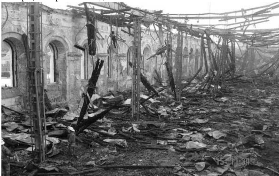
**Рис. 3. Обрушение элементов несущего каркаса**
