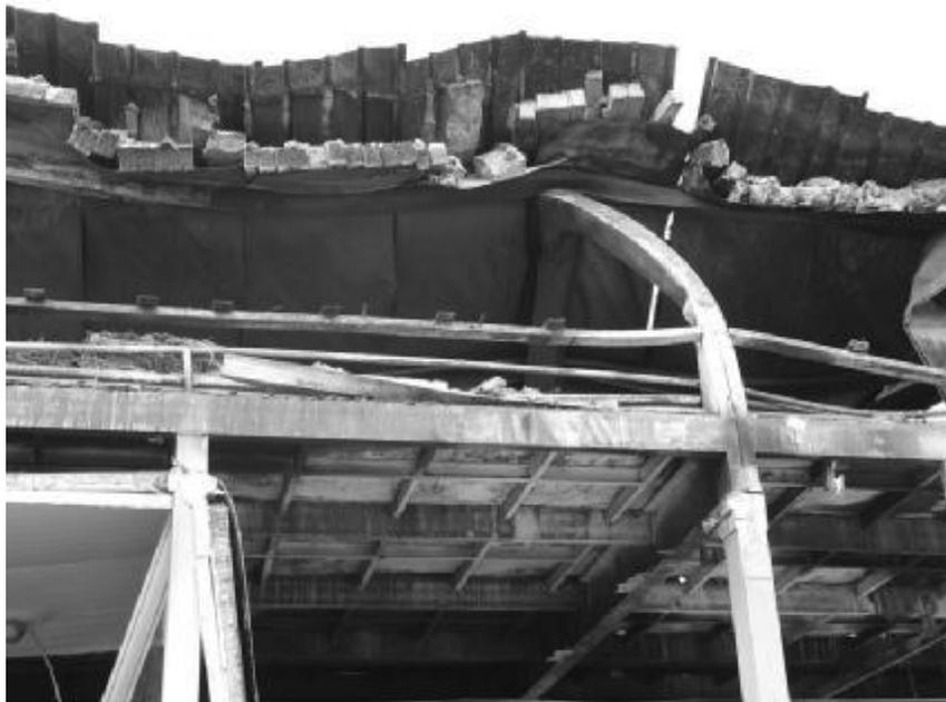
**Рис. 2. Потеря устойчивости элементов стального каркаса**
