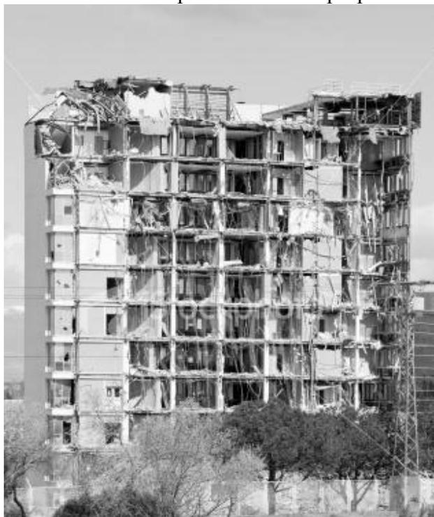
Рис. 2. Разрушение многоэтажного каркасного здания соответствующих конструктивных мероприятий, обеспечивающих недопустимость прогрессирующего обрушения, поскольку при такой схеме обрушения не могут помочь какие-либо системы контроля деформаций строительных конструкций, так как если процесс начался, то в силу его скоротечности равносильной взрыву даже предварительное обнаружение не дает возможности предпринять какие-либо предотвращения или спасения людей и оборудования.
