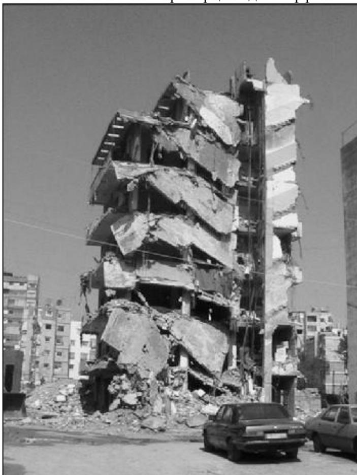
Рис.1. Взрыв газопаровоздушных смесей внутри здания
