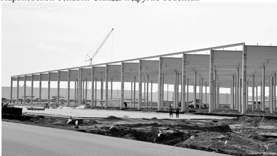
Рис. 9. Строительство Овощехранилища, площадью-6000 м 2
