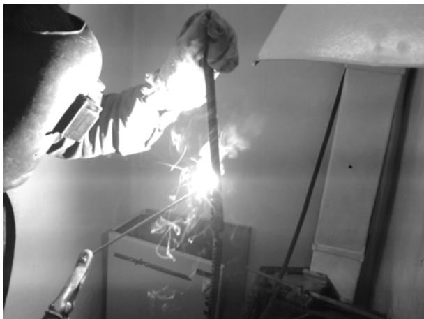
Мал.8.5. Виконання облицювальних швів
