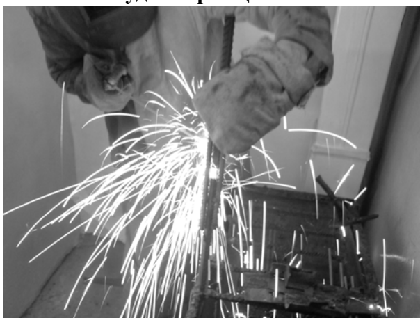
Мал. 8.3. Збирання й прихватка зварного з'єднання
