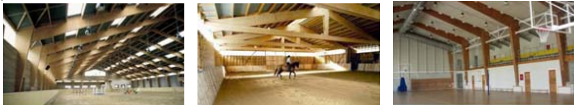
Рис. 1.1. Покрытия с использованием дощатоклеевых балок и рам.
