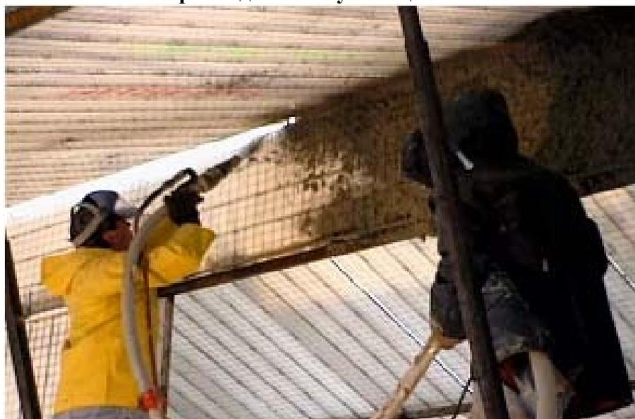
**Рис.4. Нанесение торкретбетона.**
