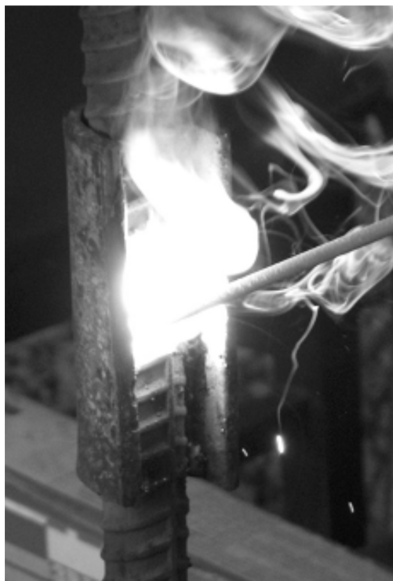
Рис. 6.1.3. Выполнение корневого шва
