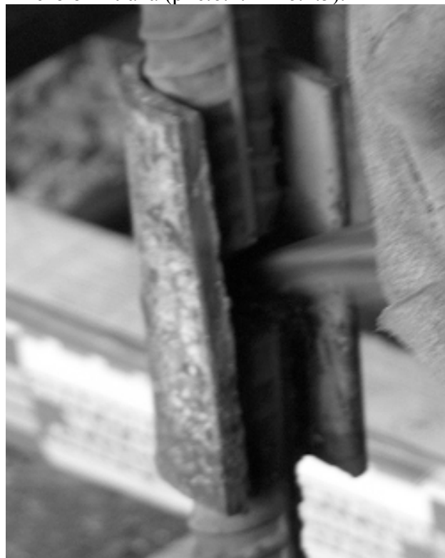
Рис. 6.1.5. Зачистка корневого шва от шлака
