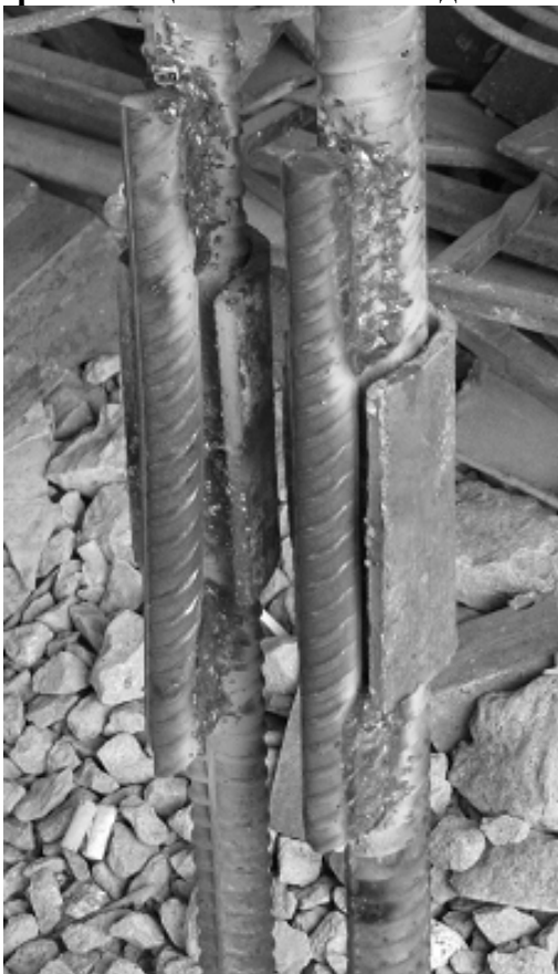
Рис. 6.2.3. Остывание сварных соединений
