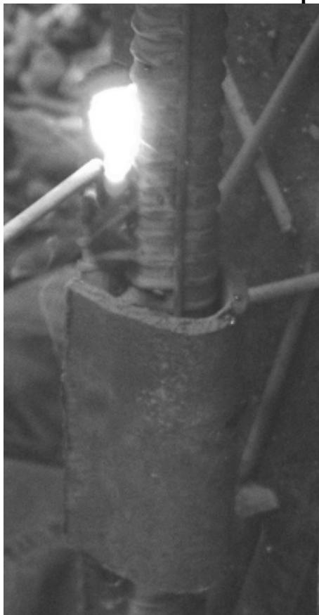
Рис. 6.2.2. Усиление дефектных сварных соединений
