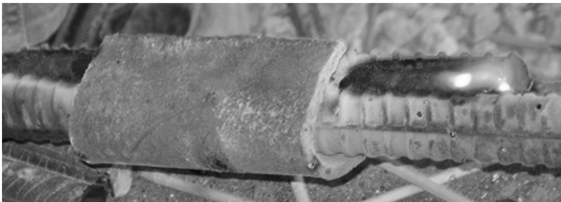
Рис. 6.2.1. Усиление сварных узлов при помощи боковой накладки.
