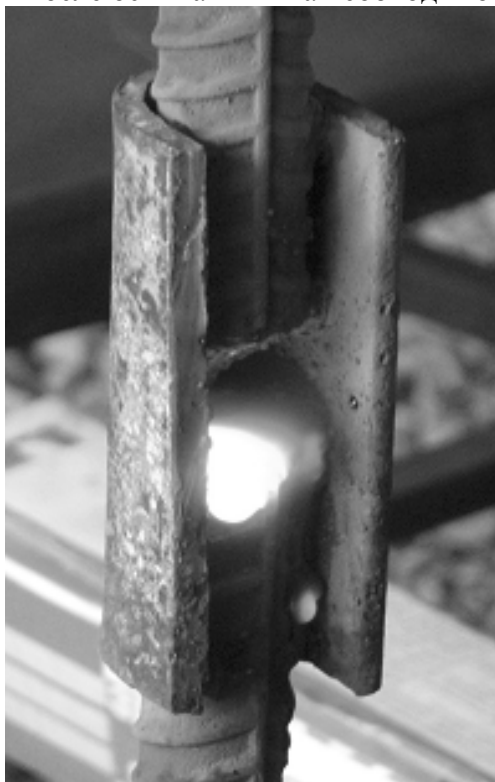
Рис. 6.1.4. Остывание корневого шва
