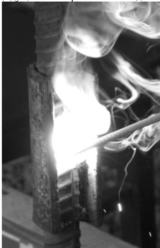
Рис. 6.1.6. Выполнение многослойных швов
