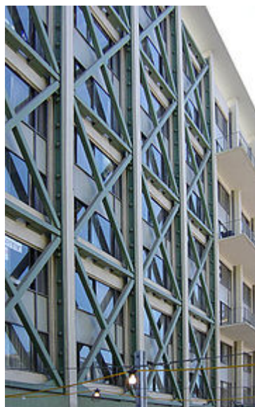
Рис.1. Наружная антисейсмическая стальная ферма спального корпуса Университета Беркли.
