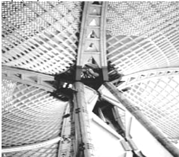
Рис. 3. Элементы деревянного каркаса, подготовленные к обработке:
