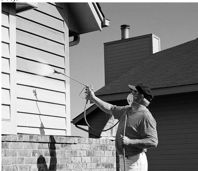
Рис. 7. Нанесение огнезащитной краски ВУП-2Д при помощи распылителя.
