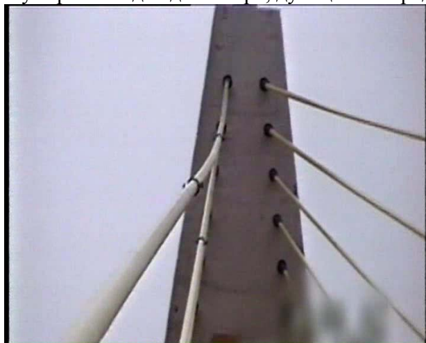
Рис. 4. Колебания троса на мосту в Бейтауне штат Техас.
