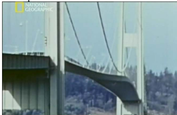
Рис.1. Изгибно-крутильные колебания моста Такома-Нэрроуз.
