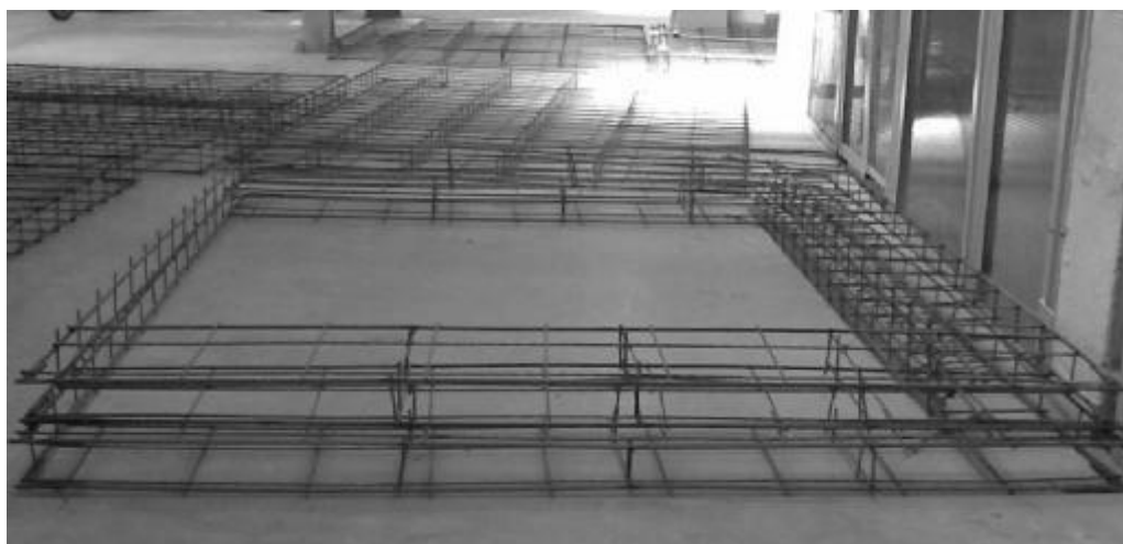
Рис.2 Пространственные арматурные каркасы стеновых панелей
