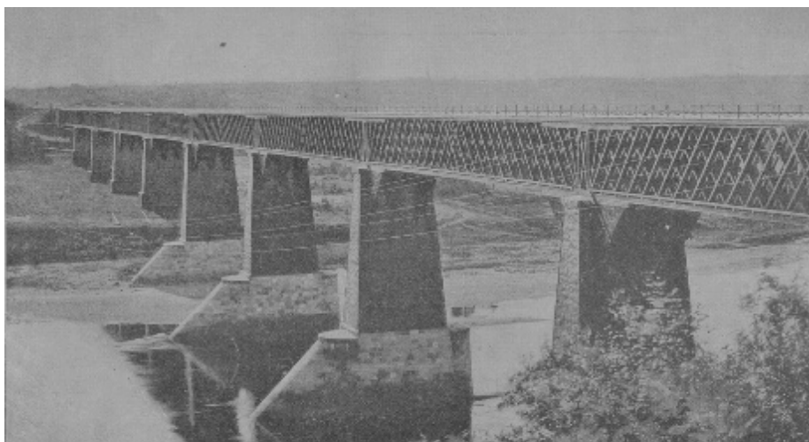
Рис. 3. Деревянный мост через р. Мсту на б. Николаевской (ныне Октябрьской) железной дороге
